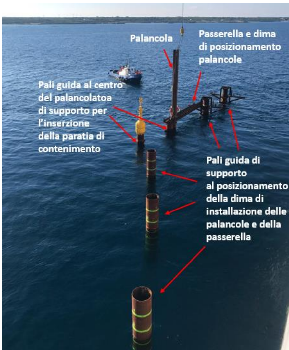
Figura 3 Installazione del palancolato temporaneo e principali elementi che lo costituiscono
